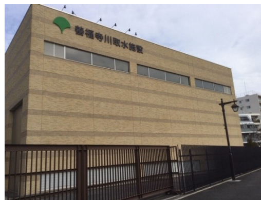
善福寺川取水施設 外観
