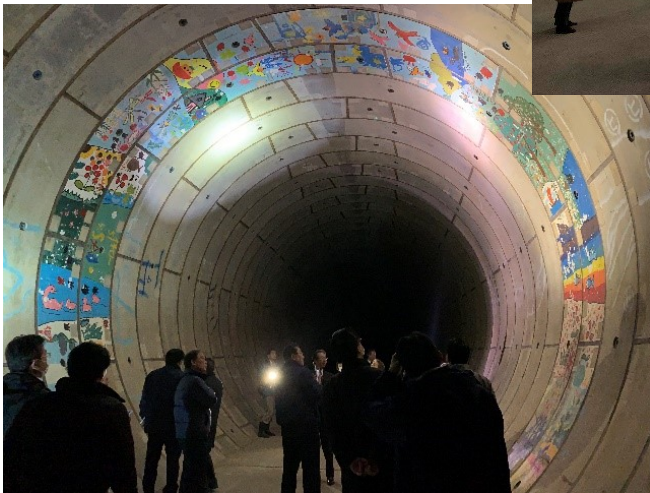
連絡管渠の途中にある地元の小学生が描いた絵
